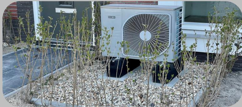
Erhält jede Wohneinheit eine eigene Wärmepumpe, entstehen insgesamt hohe Investitionskosten. Zudem besitzt jede Wärmepumpe eine Außeneinheit, die irgendwo platziert werden muss (architektonische und schalltechnische Einschränkungen).
